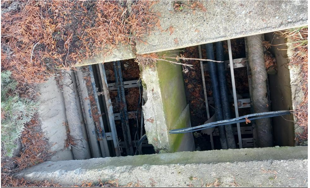
Rozdzielnica 15kV (do demontażu i wymiany na nową)
