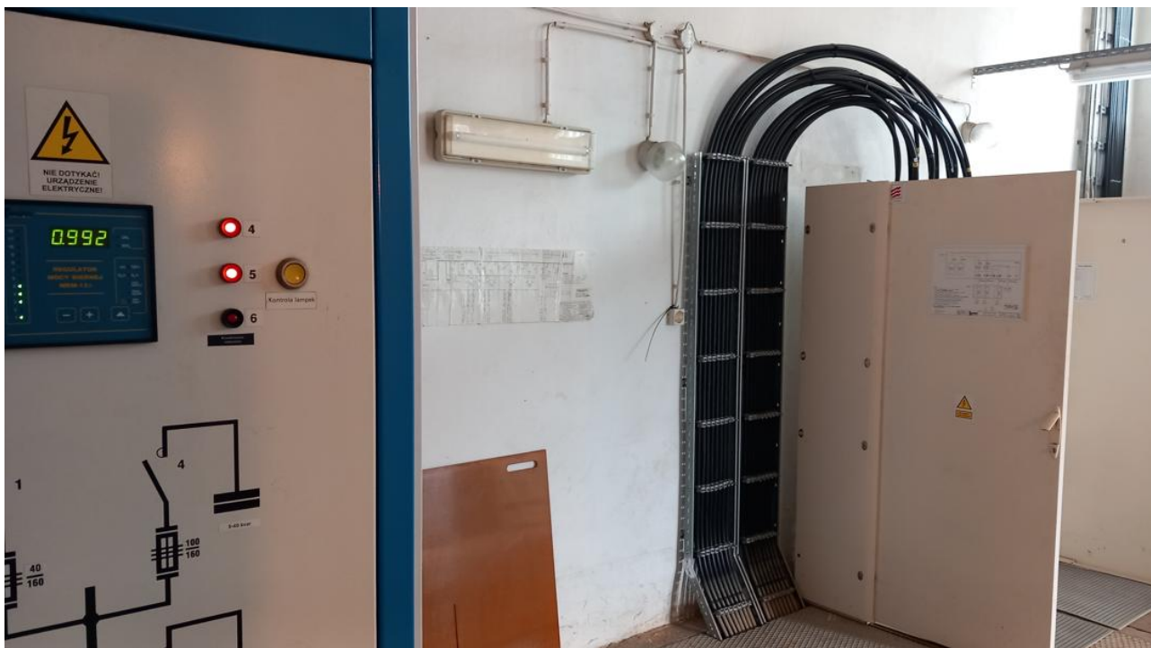
Tablica licznikowa TL oraz rozdzielnica oświetlenia zewnętrznego ROZ – bez zmian
