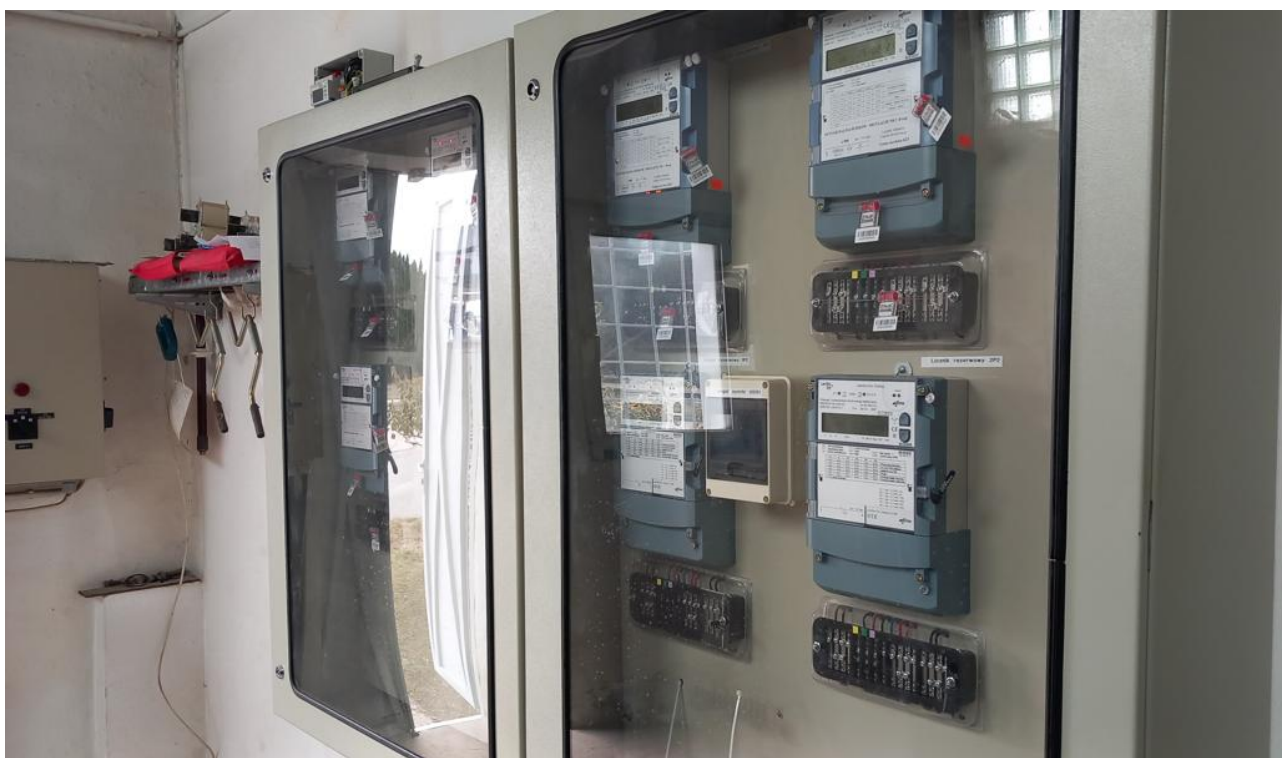
Tablica licznikowa TL oraz rozdzielnica oświetlenia zewnętrznego ROZ – bez zmian
