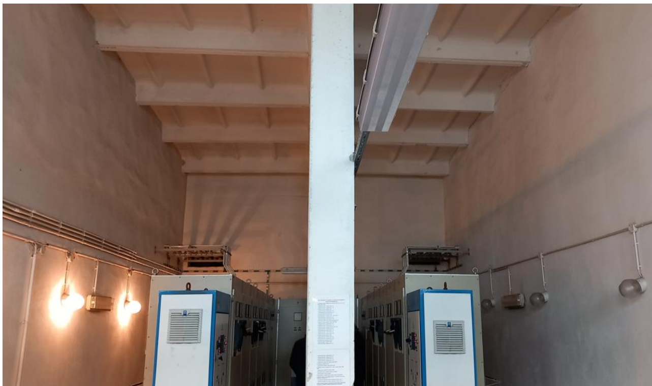
Pomieszczenie rozdzielnic głównej 400V (rozdzielnica do demontażu i wymiany na nową)
